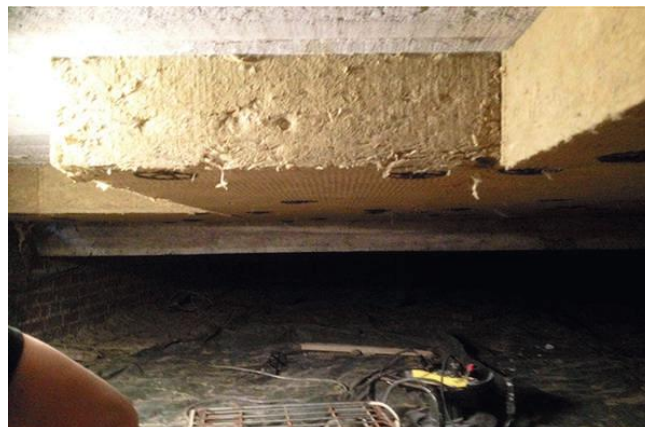
Exemple d'Isolation de vide sanitaire
